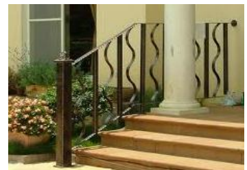
圖 19 樓梯旁設置扶手
