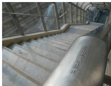
圖 21 地鐵五號線之大屯路東站樓梯上的盲文標誌
