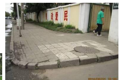
圖 4 司令街與校外街交叉口緣石坡道
