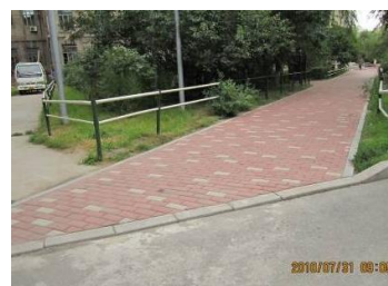
圖 5 主樓內側綠地步行道與車道交界處
