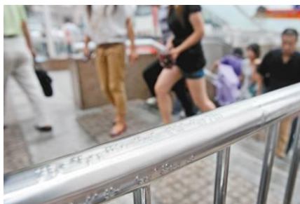
圖 20 鐘樓地下通道入口處的樓梯扶手上刻上了盲文引導資訊
